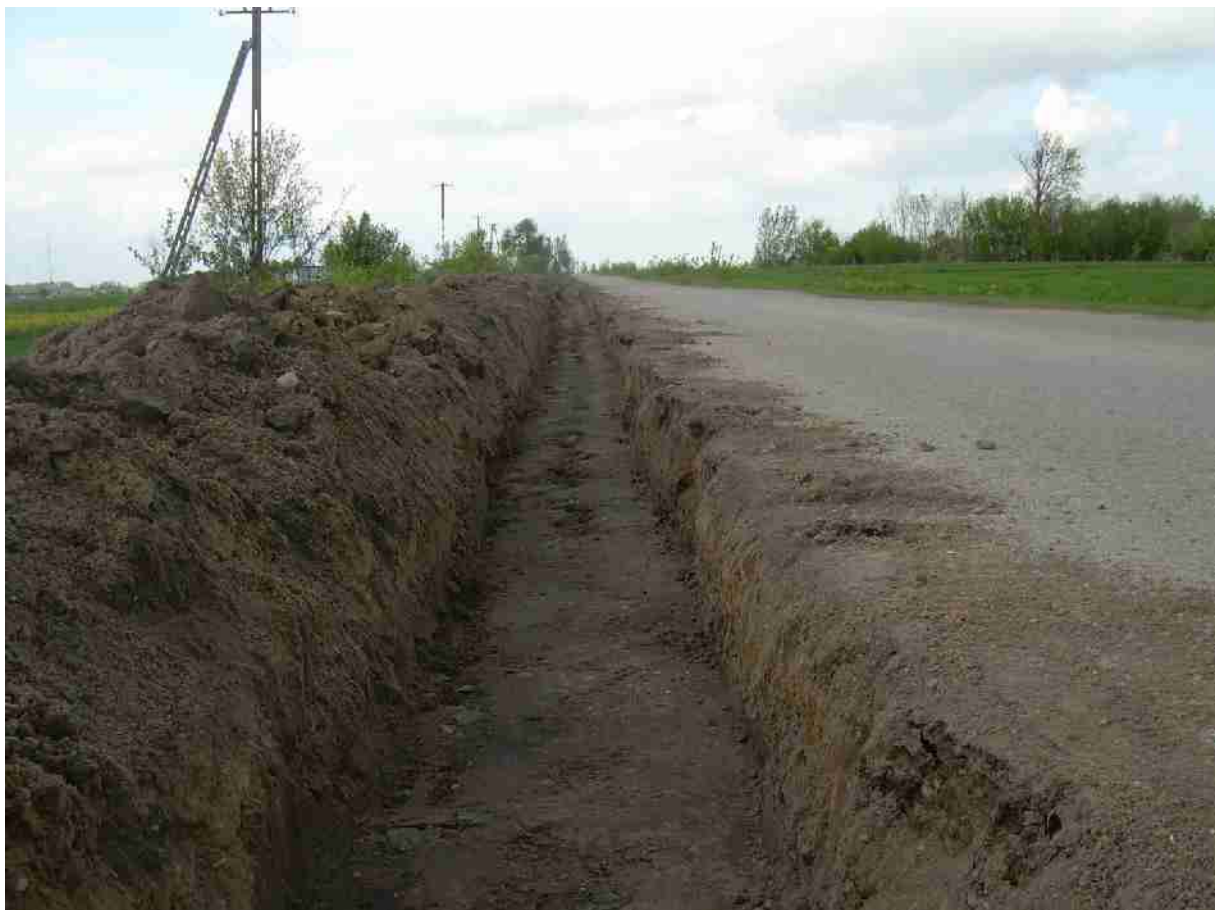
Droga Zielona - Niesiołedy - Milewo Rączki - w trakcie przebudowy /koryto pod poszerzenie jezdni/
