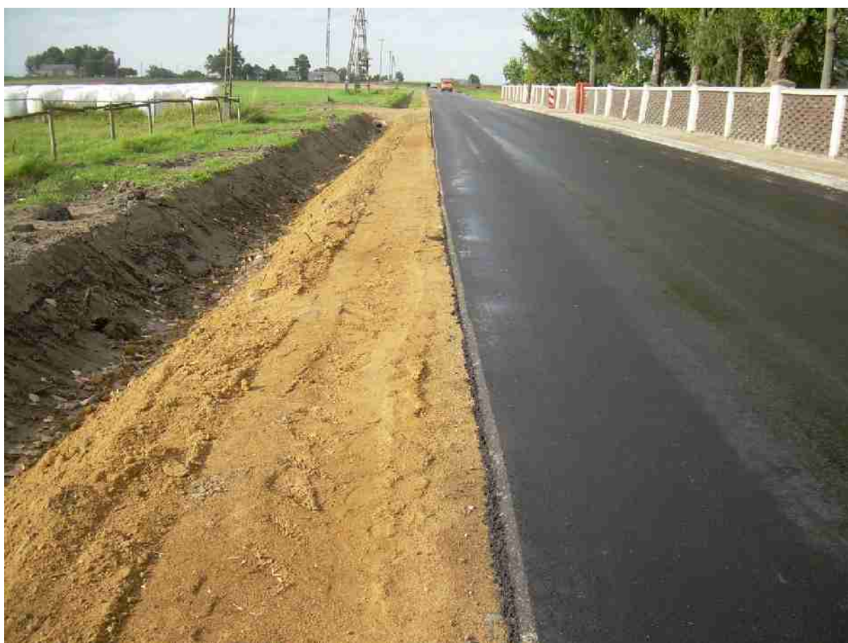
Droga Zielona - Brzozowo - układanie warstwy ścierniczej
