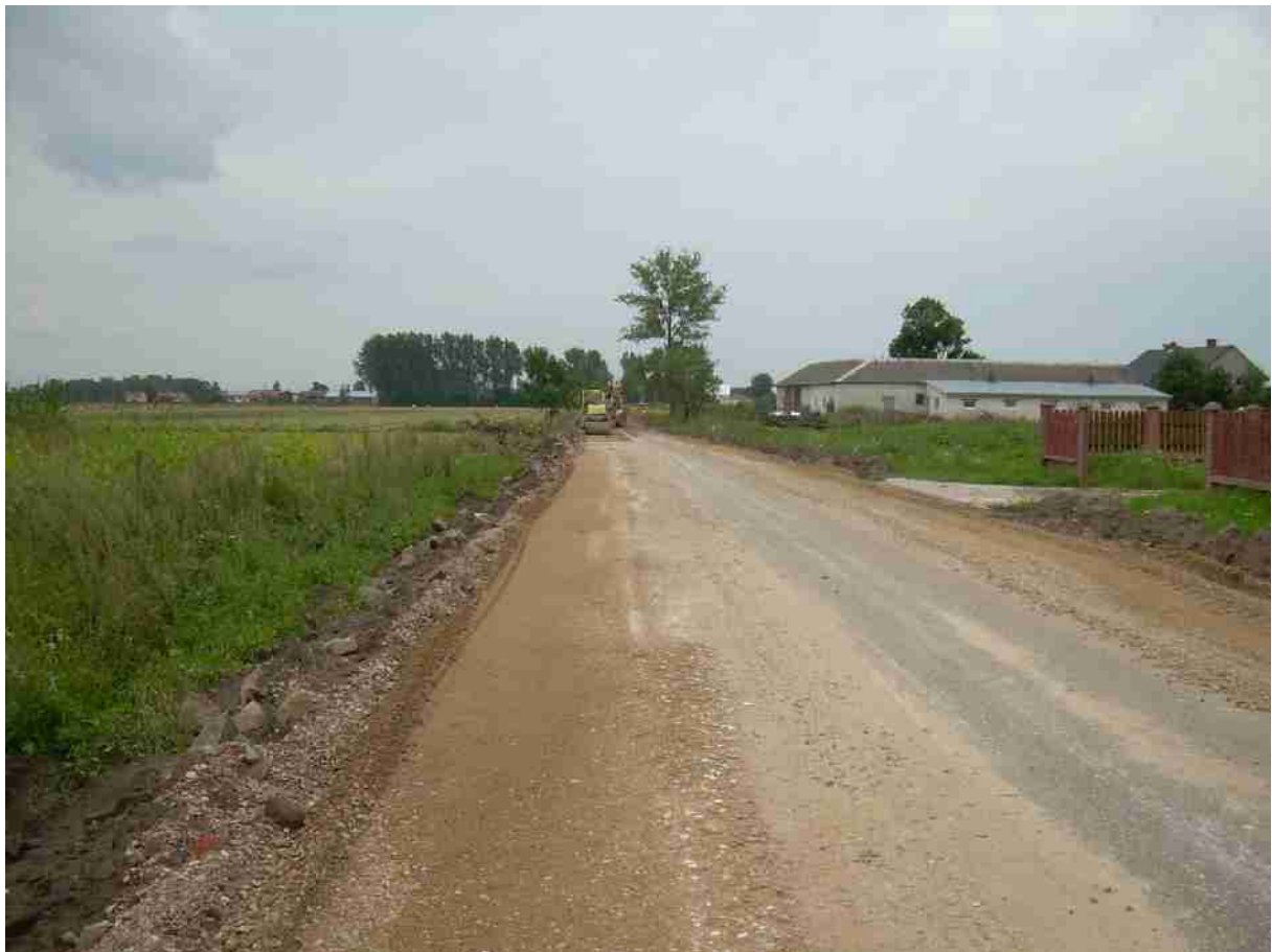
Droga Zielona - Brzozowo - poszerzenie podbudowy
