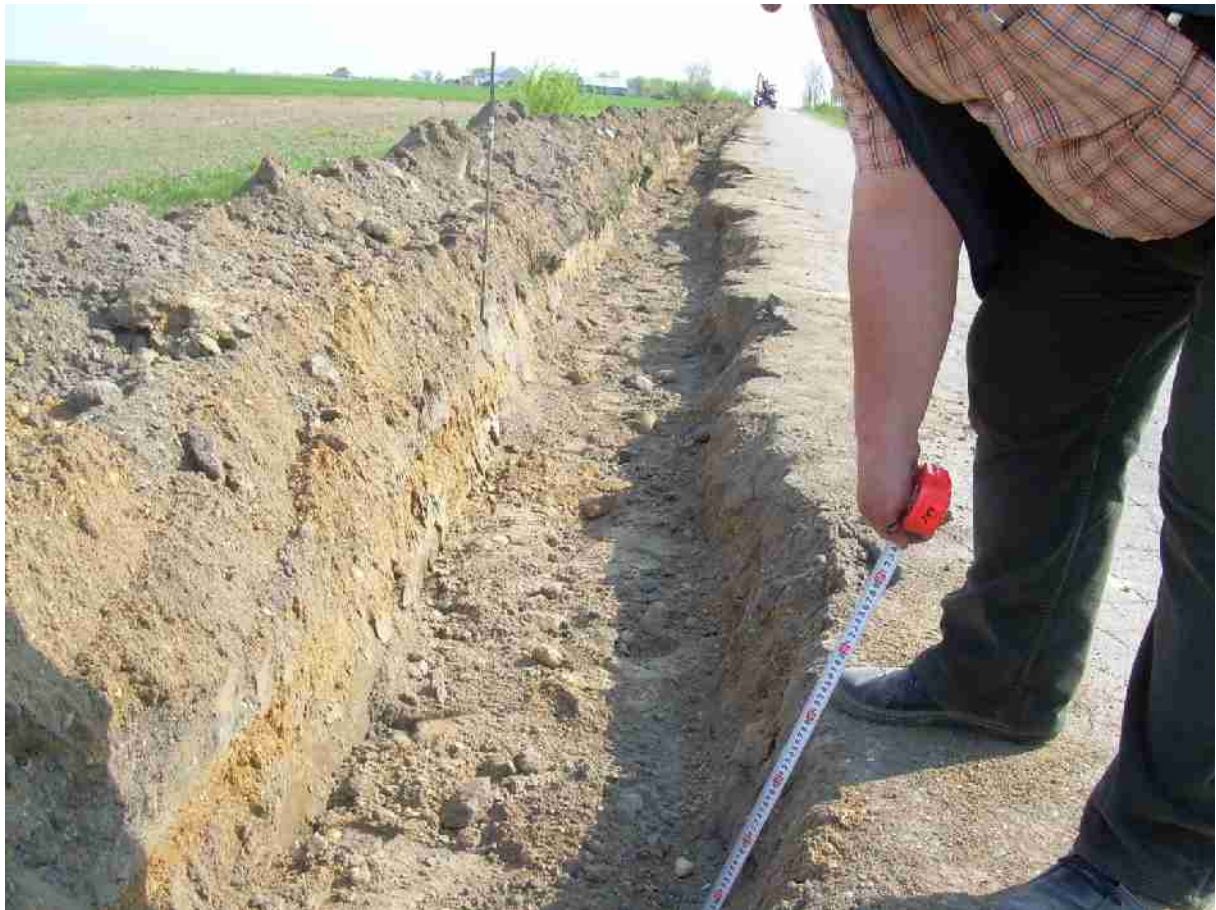
Droga Zielona - Niesiołedy - Milewo Rączki - w trakcie przebudowy /koryto pod poszerzenie jezdni/
