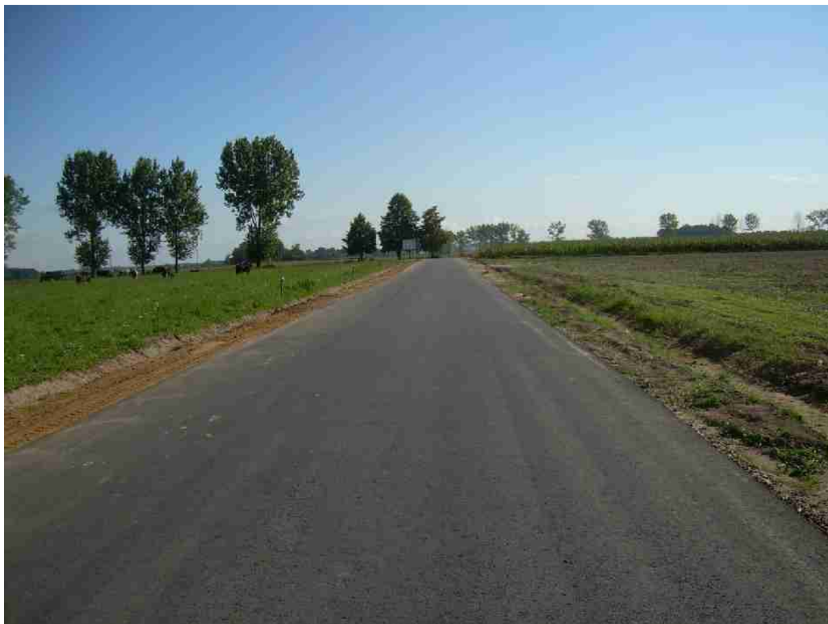
Droga Zielona - Brzozowo - ułożona dolna warstwa nawierzchni
